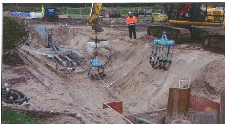
Figure 17 : Tirage au niveau de la chambre d'atterrage
