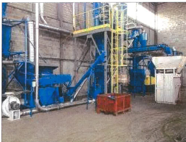
Figure 18 : Unité de broyage de câbles
